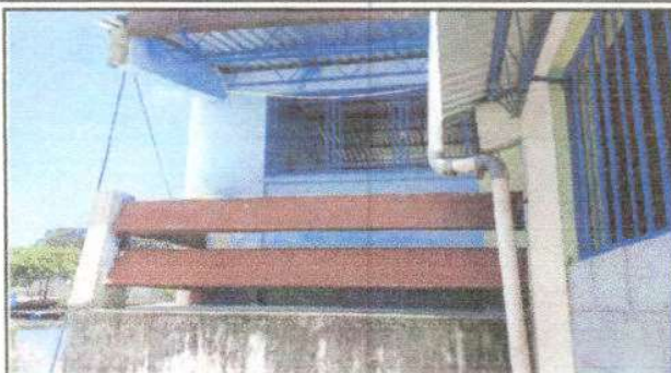
Foto 2: sustitución de duralita por lamina troquelada calibre 26 y mantenimiento de soporte de metal
