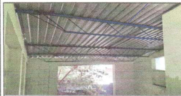
Foto 5: sustitución de duralita por lamina troquelada calibre 26 y mantenimiento de soporte de metal
